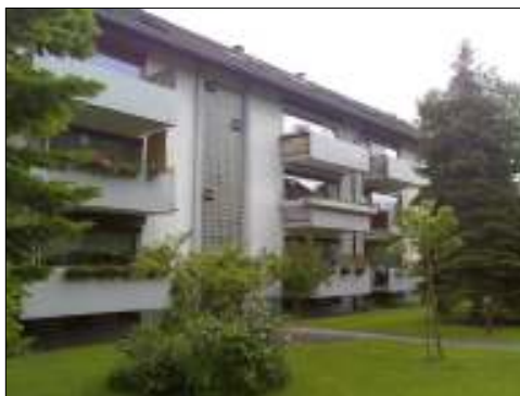
Die Wohnanlage in der Frankenstraße vor der Sanierung.
