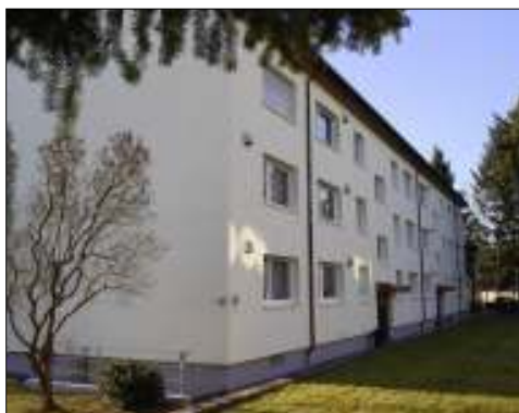
Das Mehrfamilienhaus nach der Komplettsanierung.
