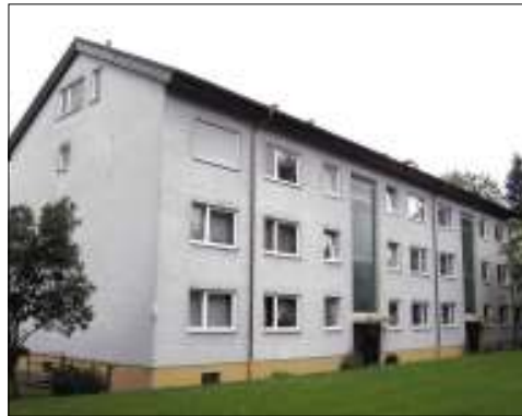
Ein Bild aus vergangenen Tagen: Dieses 12-Familien-Wohnhaus in der Wiesenstraße wurde in drei Bauabschnitten komplett saniert.
